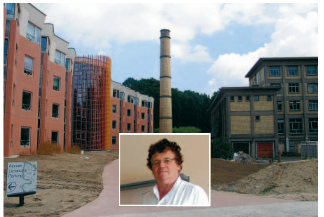
A droite l'ancien home, à gauche le nouveau (arch.: ART/P. Farla). Au milieu, Johan Vanlathem. ■ C.T.
